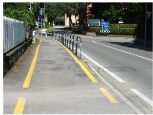
Anche in questo tratto il percorso si sviluppa su marciapiede separato da archetti con una sezione piuttosto ridotta per un ciclopedonale. In questo caso i flussi, sia pedonali che ciclabili, sono inferiori che a Formigine e le criticità si evidenziano con meno forza.
