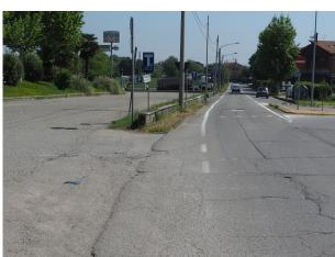
Il percorso potrebbe poi proseguire fino ad arrivare a Ponte Fossa. In un primo tratto sfruttando il cordolo esistente si realizza un percorso ciclabile rialzato, senza andare a modificare il sistema di raccolta delle acque, e valutando se restringere la sezione per evitare espropri.
