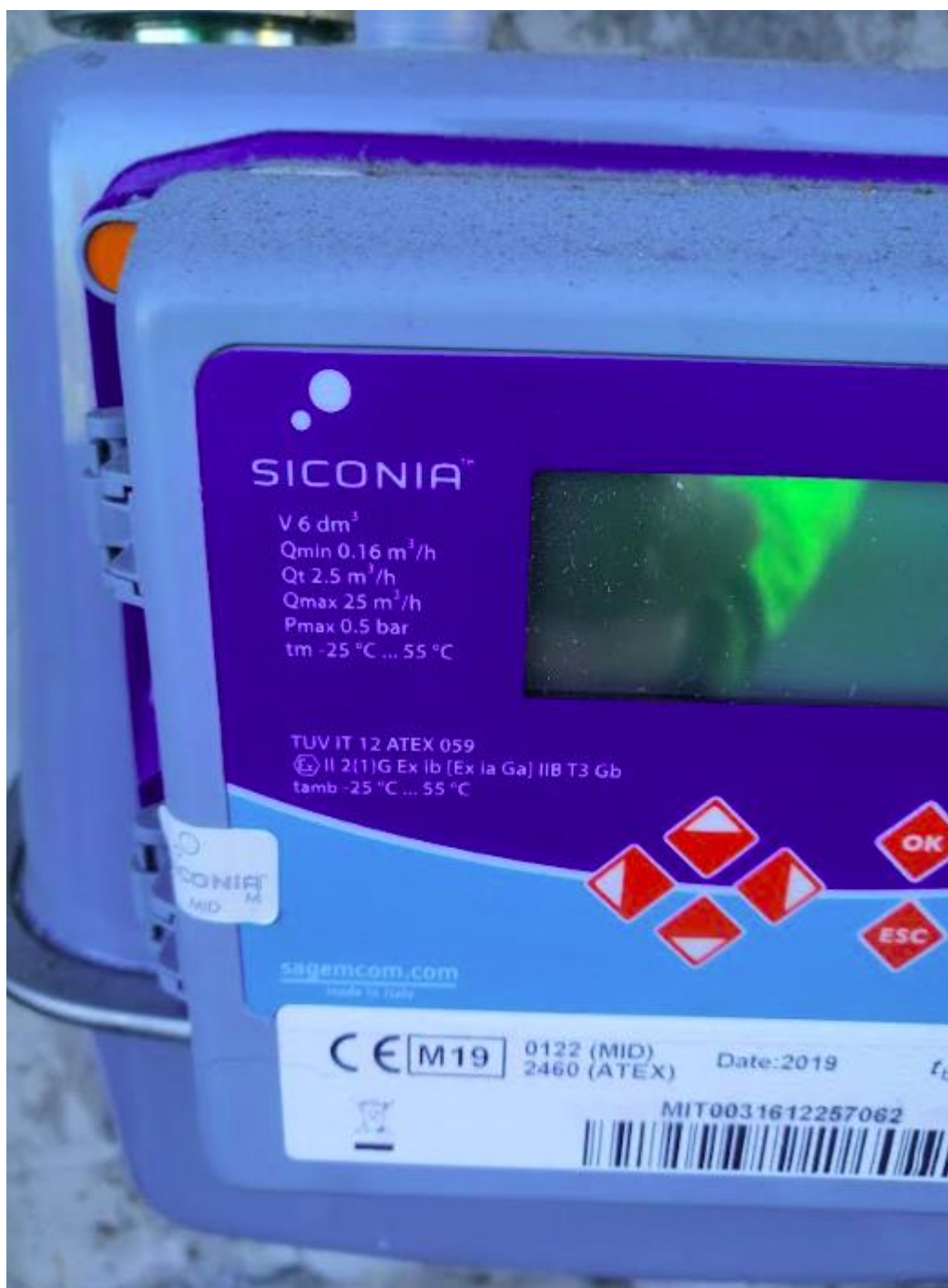
Figura 3: rete GAS – CONTATORE ESISTENTE
