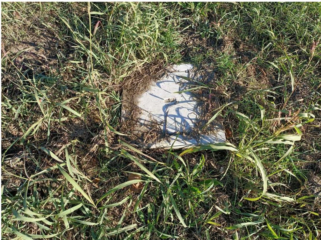
**Foto 30** – Via Circonvallazione Sud-Ovest – Pozzetto Cls Dim. Cm 40x40 interno
