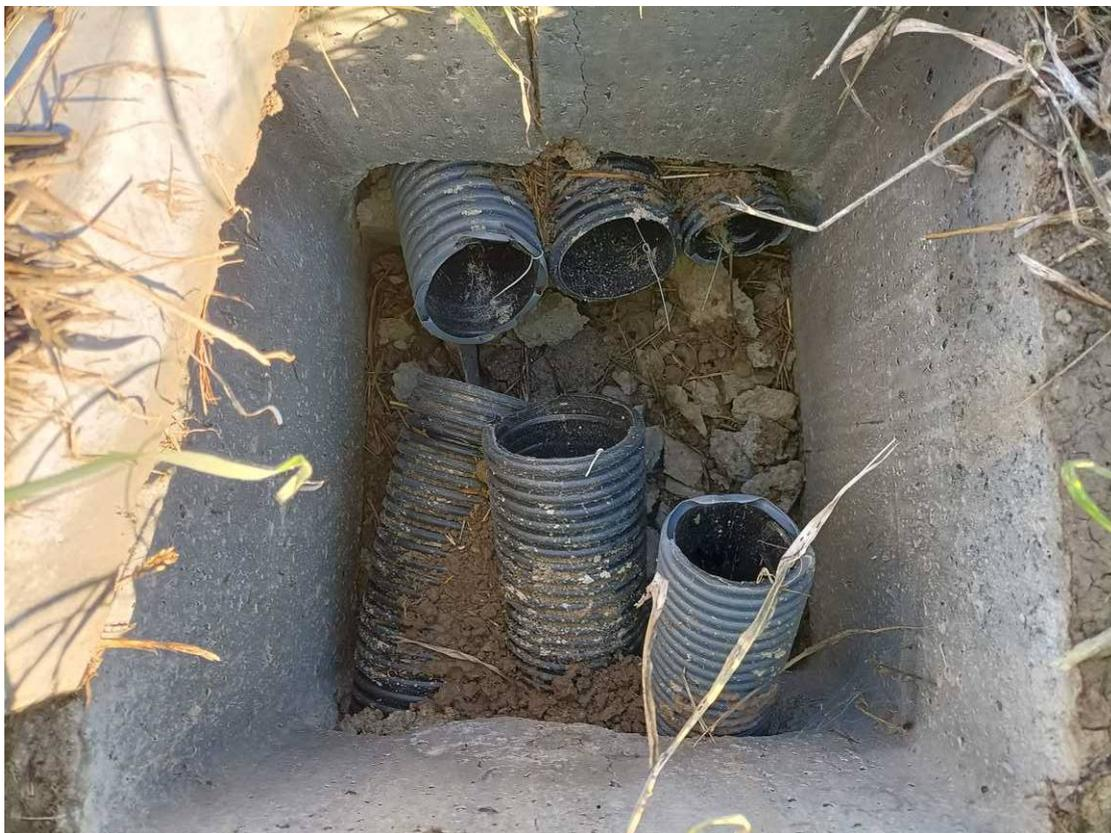
**Foto 28** – Via Circonvallazione Sud-Ovest – Nr. 3 Cavidotti flessibili DN110, DN110 e DN90
