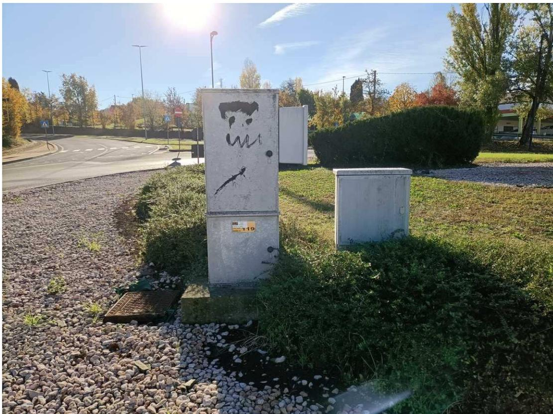
Foto 20 – Rotatoria Via Montanara (Quadro esistente IP nr. 119 e Controllore di Potenza)
