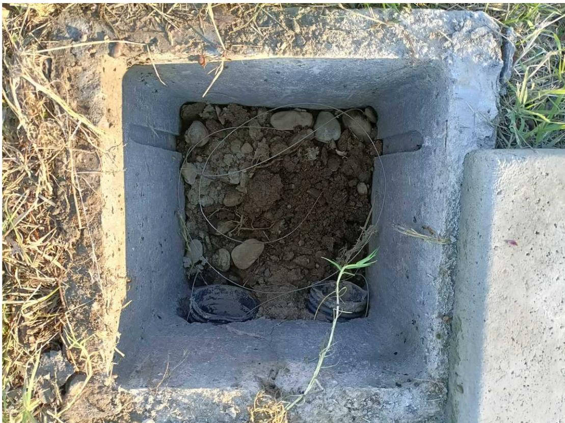
**Foto 38** – Via Circonvallazione Sud-Ovest – Nr. 2 Cavidotti flessibili DN110 e DN90
