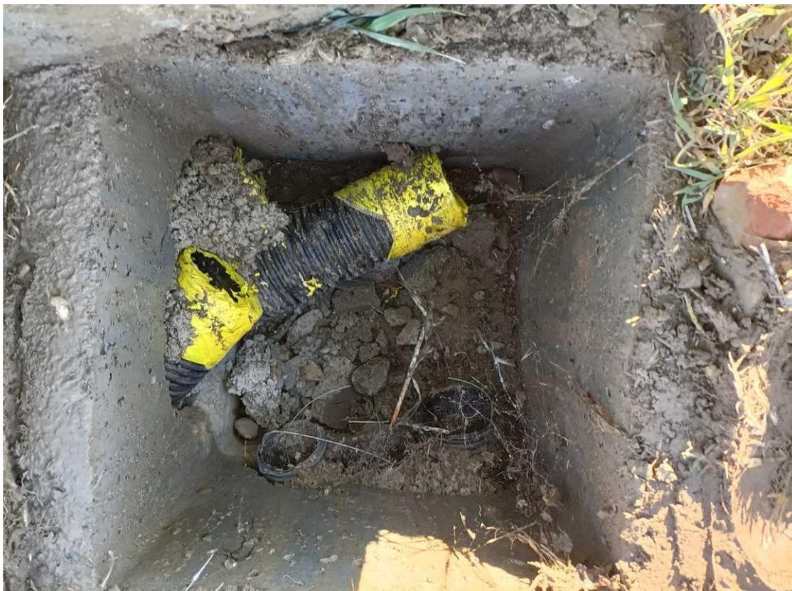
**Foto 24** – Via Circonvallazione Sud-Ovest (Curvone) – Nr. 3 Cavidotti flessibili DN110, DN110 e DN90
