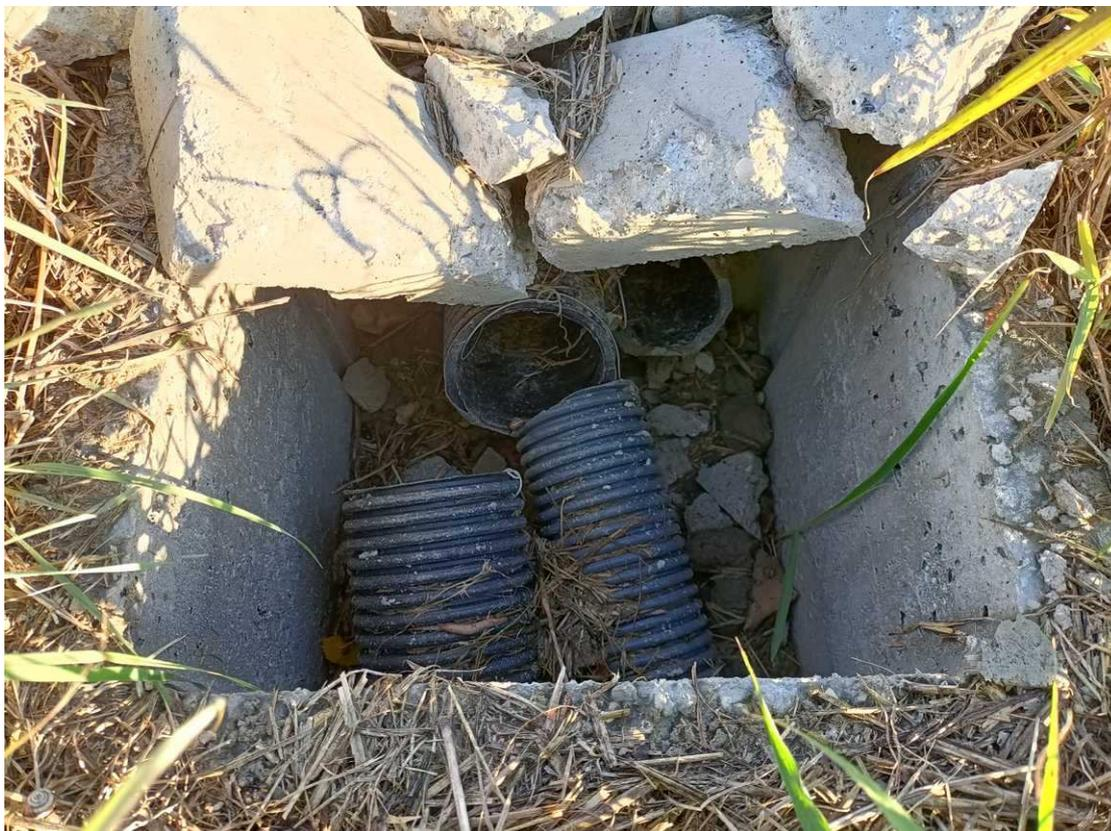
**Foto 34** – Via Circonvallazione Sud-Ovest – Nr. 2 Cavidotti flessibili DN110 e DN90
