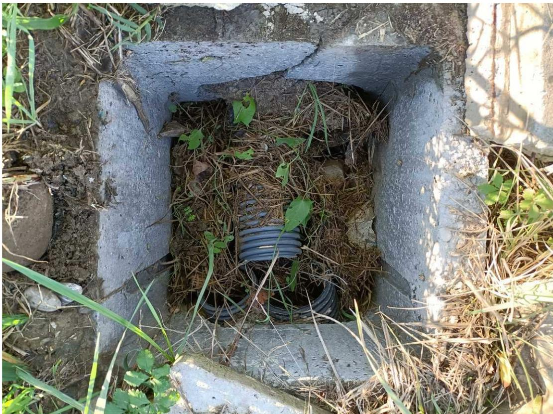
**Foto 36** – Via Circonvallazione Sud-Ovest – Nr. 2 Cavidotti flessibili DN110 e DN90
