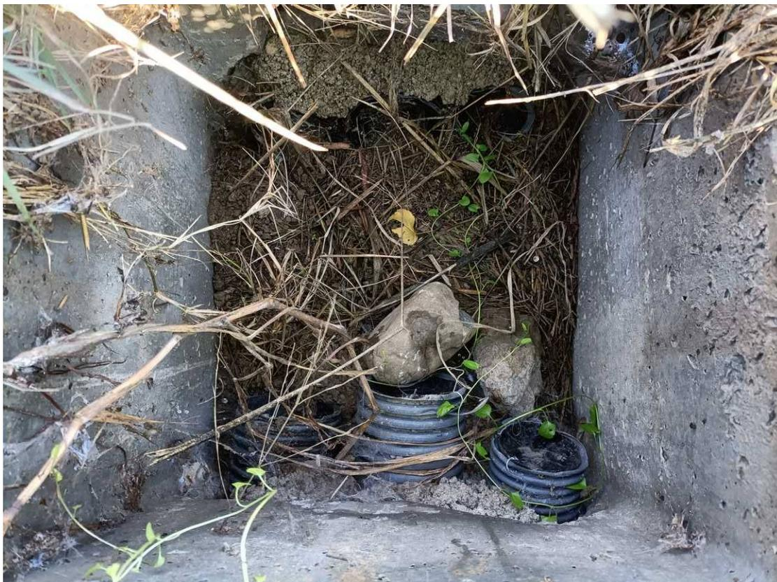
**Foto 26** – Via Circonvallazione Sud-Ovest – Nr. 3 Cavidotti flessibili DN110, DN110 e DN90
