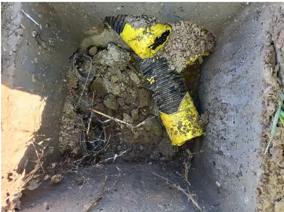
**Foto 23** – Via Circonvallazione Sud-Ovest (Curvone) – Nr. 3 Cavidotti flessibili DN110, DN110 e DN90
