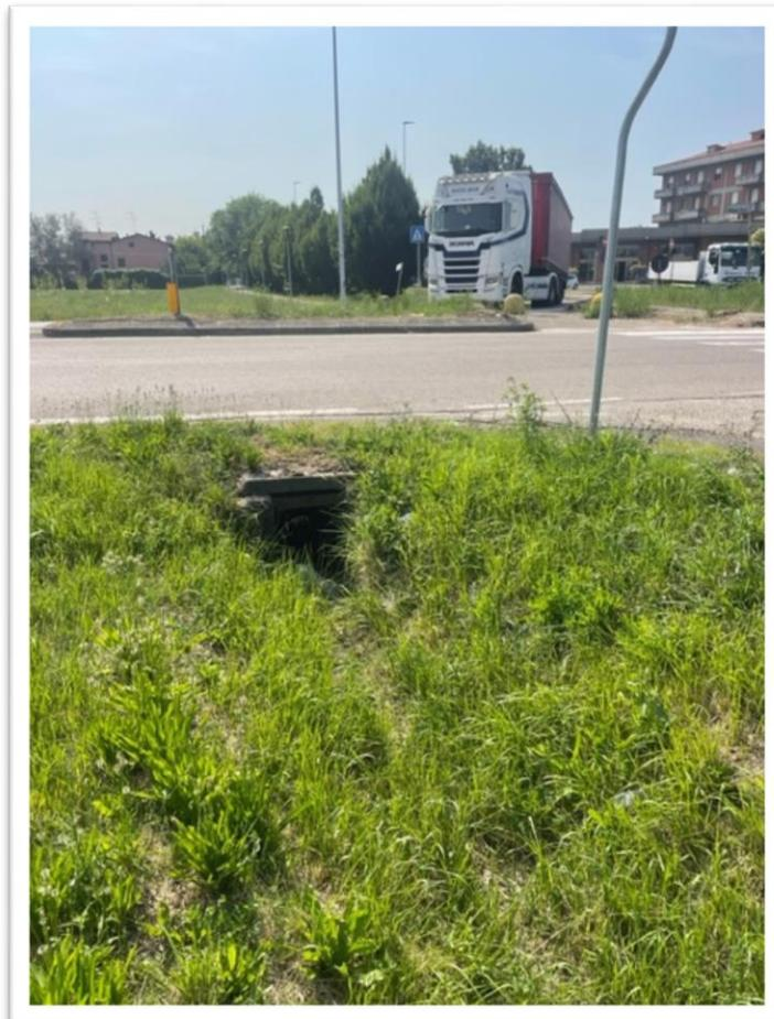
**Foto 4** – Via Regina Pacis: fosso di raccolta acque in prossimità della rotatoria, in parte da tombare, parallelo a Via Frati Str.Bassa
